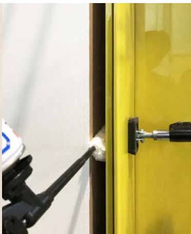
Kotvení montážní pěnou
